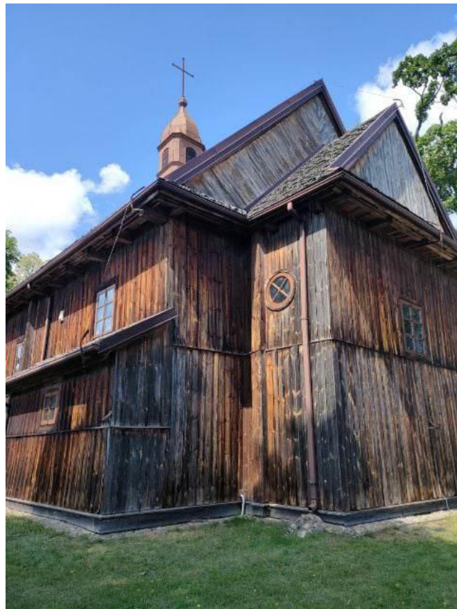
Nr. 2 elewacja południowo - wschodnia
